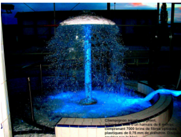
Champignon éclairant d'un petit bassin de piscine
